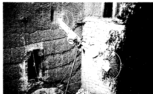
Fig. 9. Een tweetal beschermroosters van ventilatoren. Die dingen lijken natuurlijk verleidelijk veel op schotelantennes. Wie goed kijkt ontdekt in dit kunstwerk ook het enige functionele onderdeel: een gevouwen dipool.
